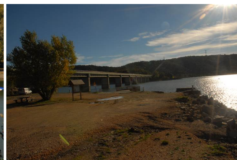
Vue sur le Pont de Pré Clauou depuis les berges aménagées.
