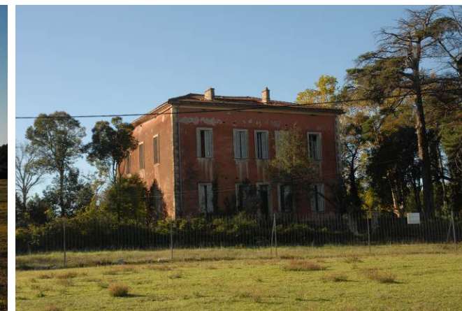
Château de Grime en chantier.
