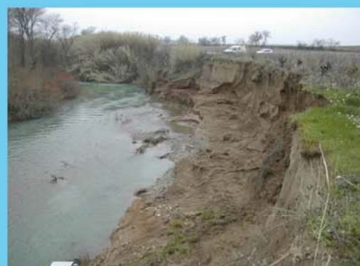
Erosion de la berge en absence de ripisylve
