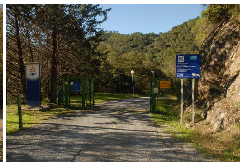
Route menant au barrage de St-Cassien. Elle est fermée par EDF.
