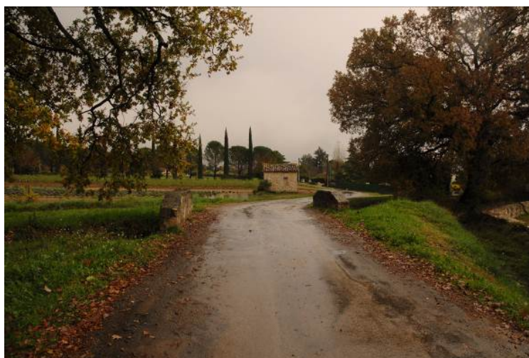
Pont maçonné sur un ruisseau et cabanon isolé (secteur de la Chapelle ND-des-Cyprés).
