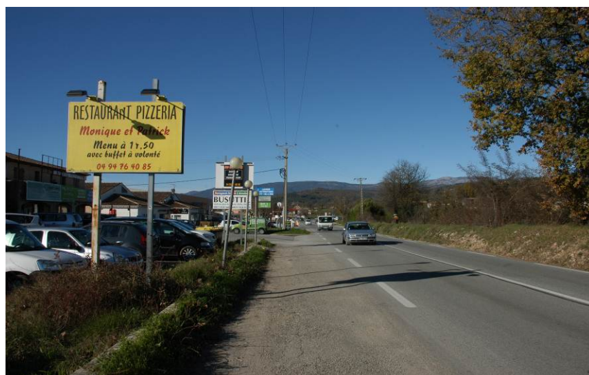
RD562 rectiligne bordée de panneaux publicitaire et de zones d'activités accessibles par des contre-allées.
