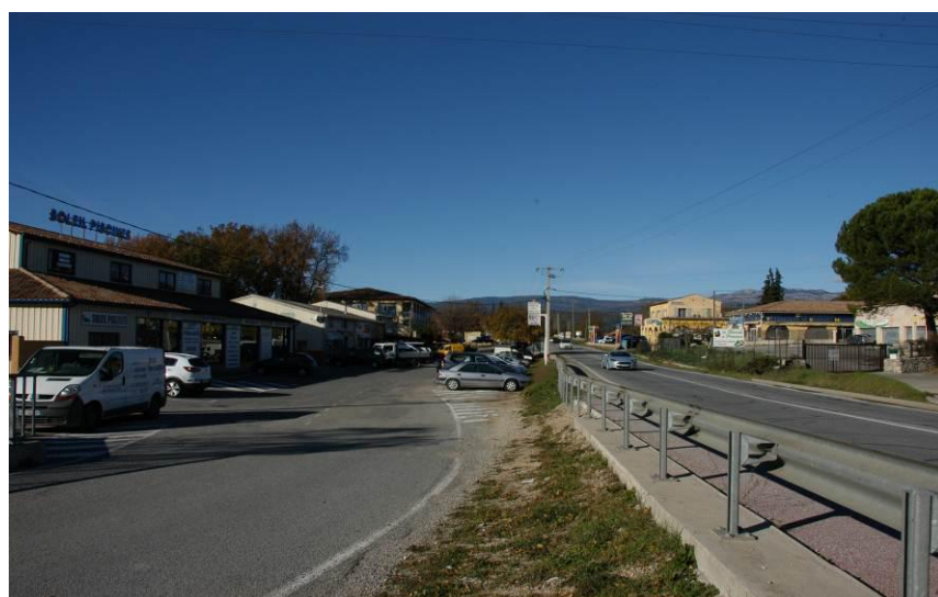
Zone d'activité et sa contre-allée au bord de la route RD562.
