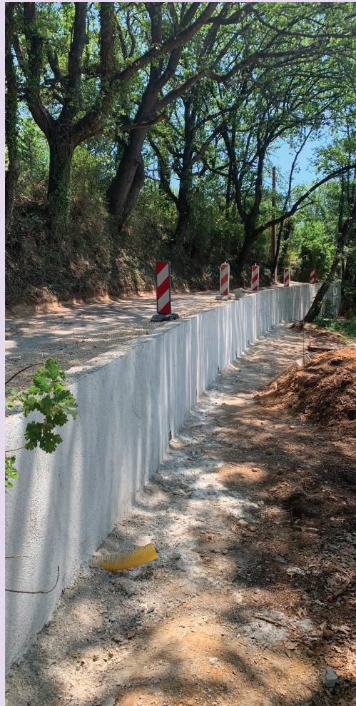
Création d'un mur de soutènement afin de stabiliser et ainsi sécuriser le chemin de Mayan.
