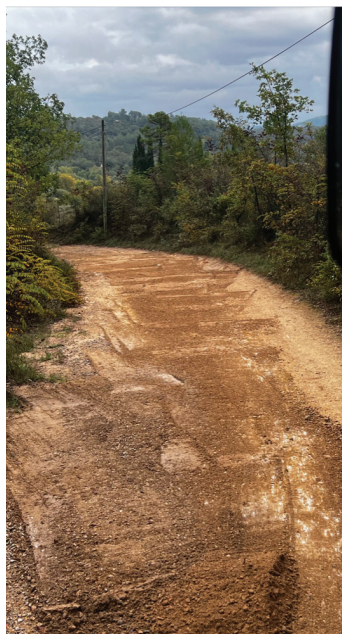
Remise en état de la piste communale du Serminier
