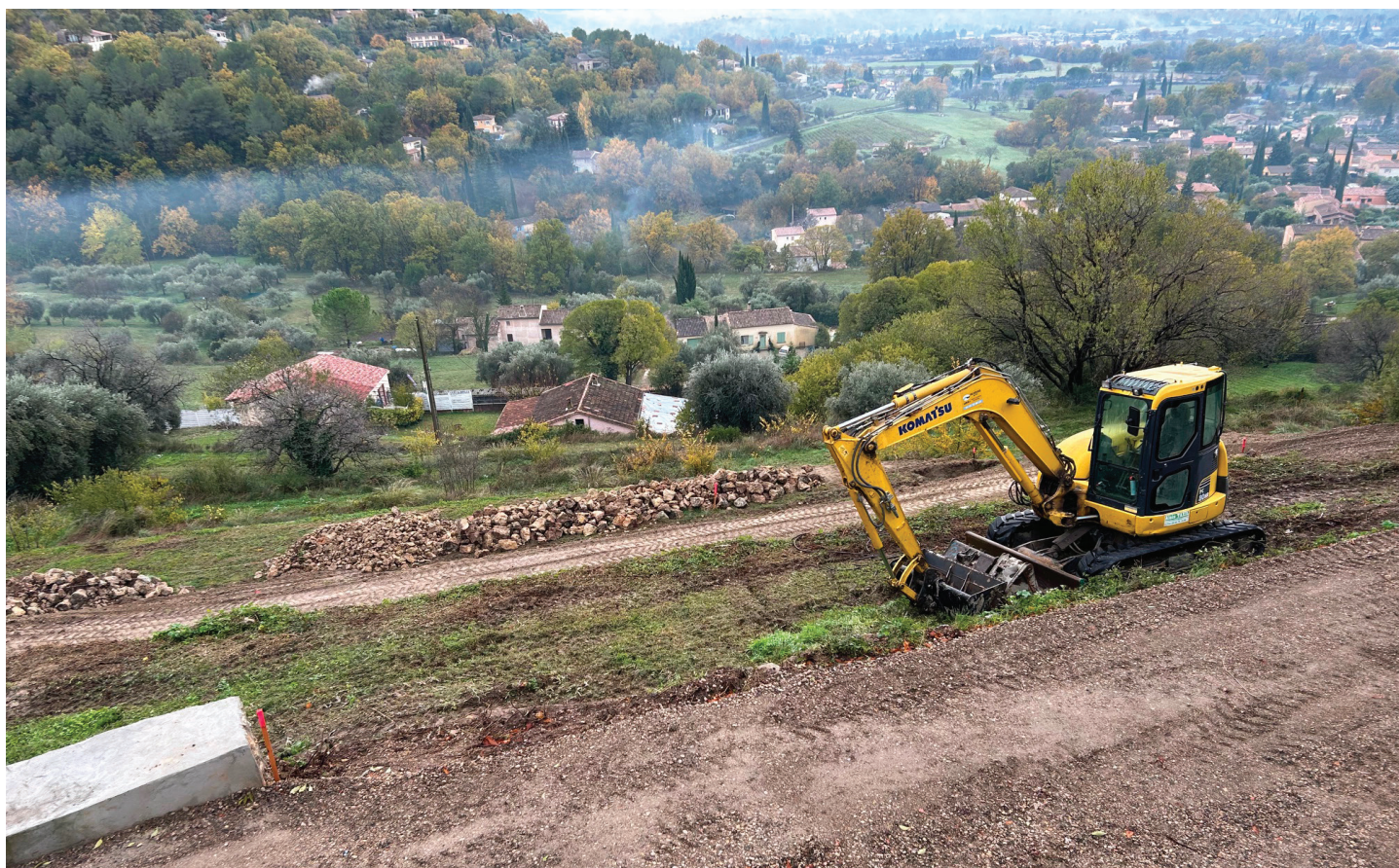
Premier coup de pelle pour débuter le chantier de construction du parking « Saint-Roch ». La quarantaine de places de stationnement prévues seront très utiles pour désengorger le bas du village.
